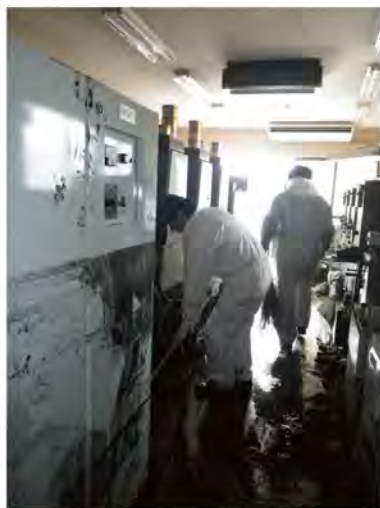
写真19 胸まで浸水した機械の復旧作業
