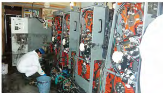
写真18 津波被害後の機械内部点検
