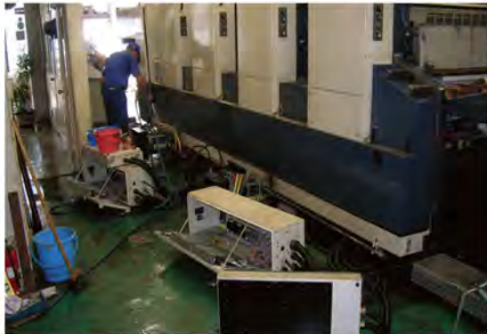
写真 15 電気配電盤を乾燥させて復旧作業中
