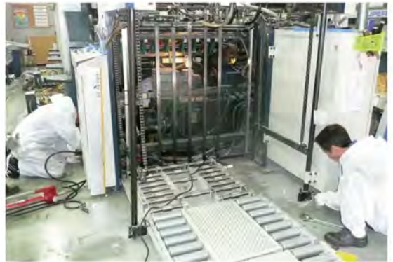
写真5 使い捨て作業服で復旧作業中
